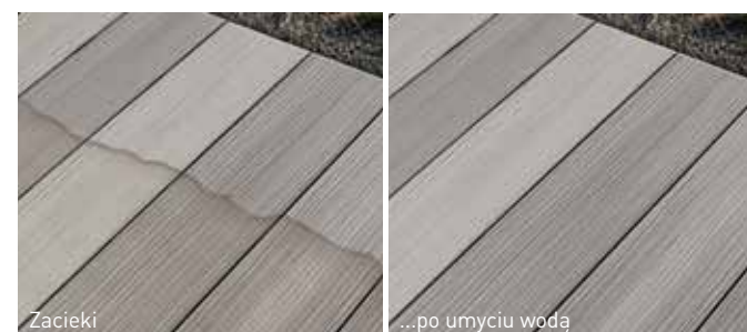
Zacieki ...po umyciu wodą
